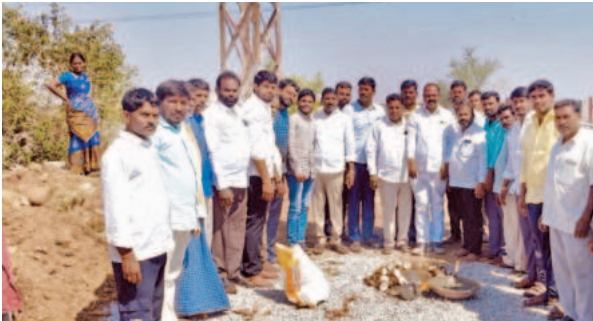
సిని రోడ్డు పనులను ప్రారంభిస్తున్న అధికారులు
